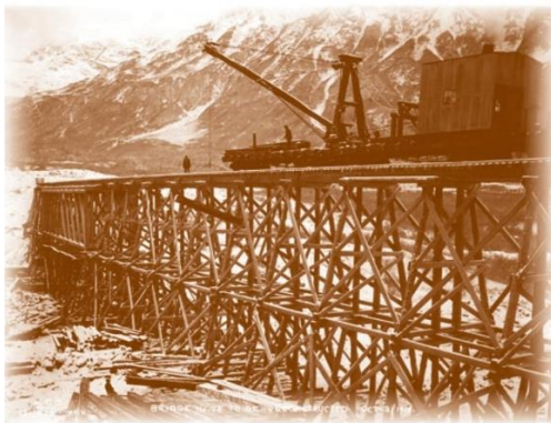
La reconstruction d'un pont de bois, 1919.
