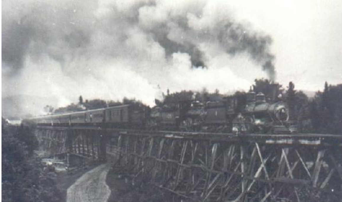
Pont ferroviaire au-dessus de la rivière Cascapédia, avec ses nombreux chevalets de bois (« trestles »), vers 1890-1900. On y remarque le passage sous les rails pour les voitures à cheval, puis les automobiles.
