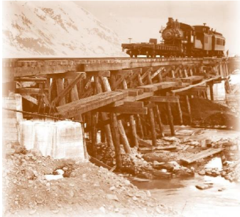
Construction d'un pont de bois.
